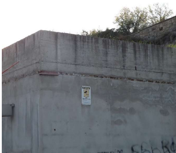
Foto 24 – Vista delle macchie sul fascione di copertura
