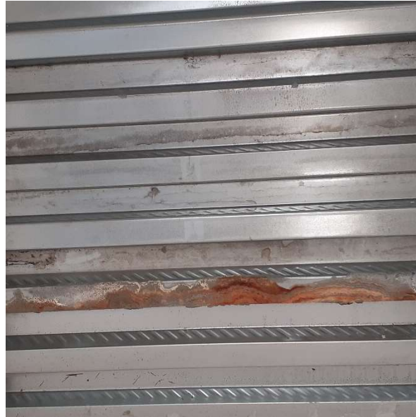
Foto 29 – Vista sull'ossidazione della lamiera grecata
