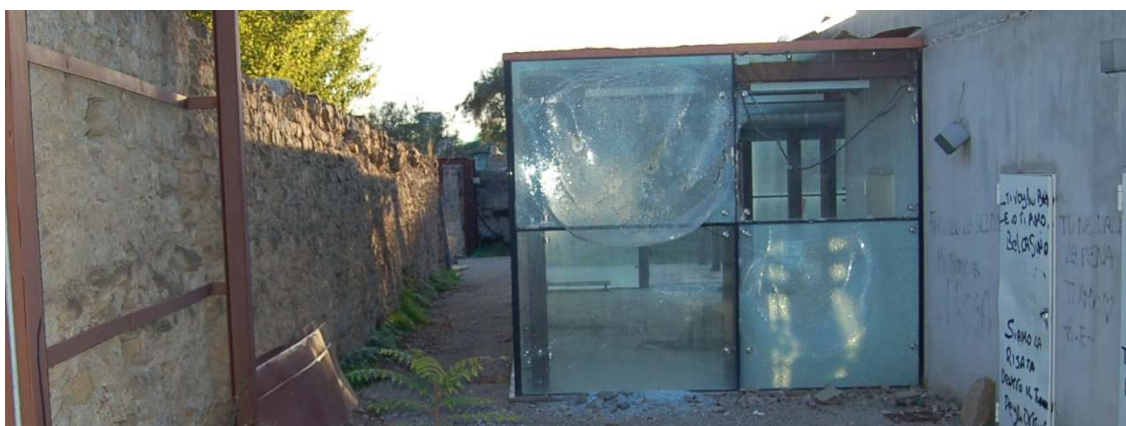
Foto 13 – Vista delle lastre di vetro stratificato rotte del prospetto est
