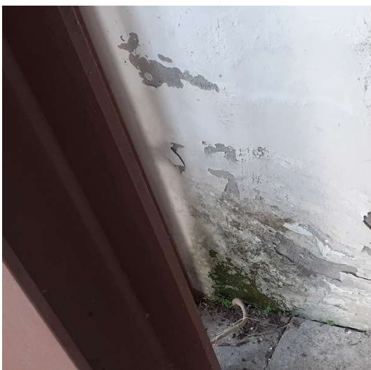
Foto 30 – Vista del degrado da umidità di risalita
