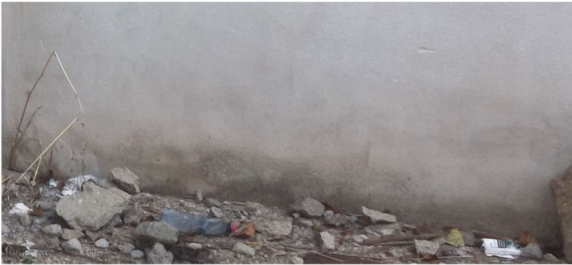
Foto 25 – Vista sul degrado delle pareti esterne dovuto ad umidità ascendente
