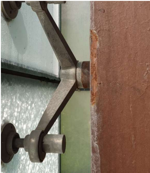
Foto 28 – Vista dell'ossidazione del metallo
