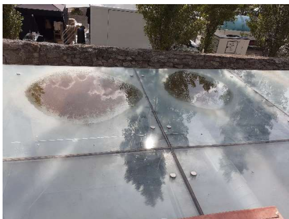
Foto 21 – Vista del ristagno di acque meteoriche
