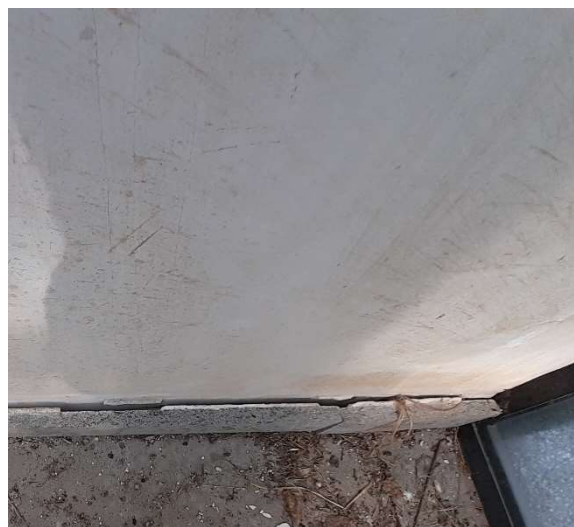
Foto 31 – Vista del distacco del battiscopa
