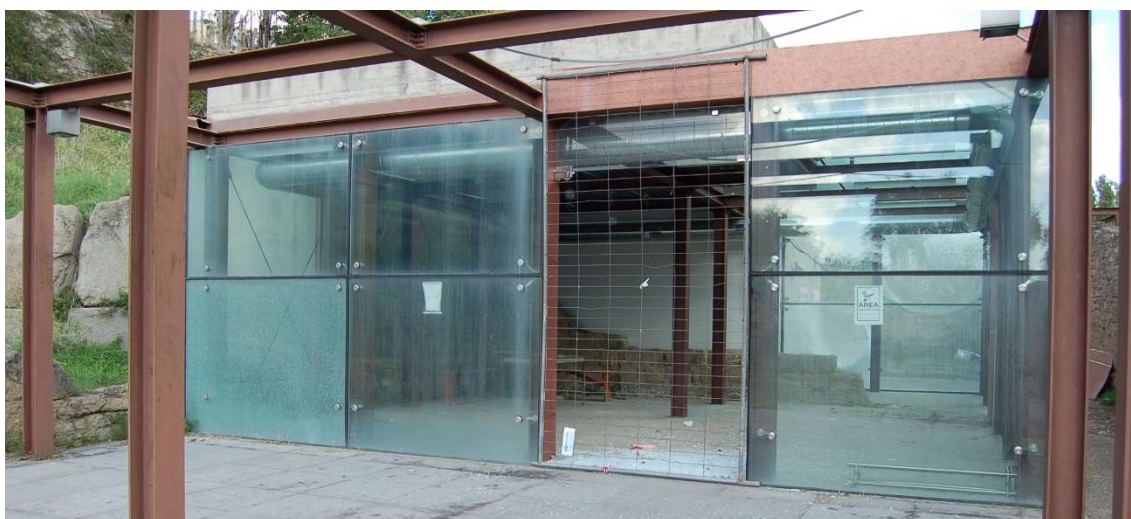
Foto 12 – Vista delle lastre di vetro stratificato rotte del prospetto principale e della porta di ingresso frantumata
