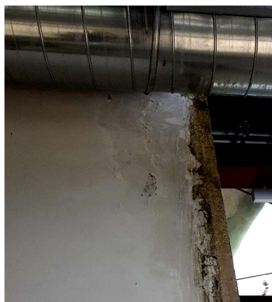
Foto 27 – Vista del degrado sull'intonaco distaccato
