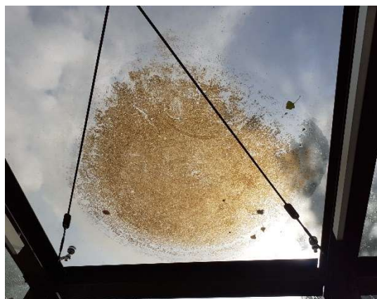
Foto 22 – Vista delle macchie sulla copertura in vetro
