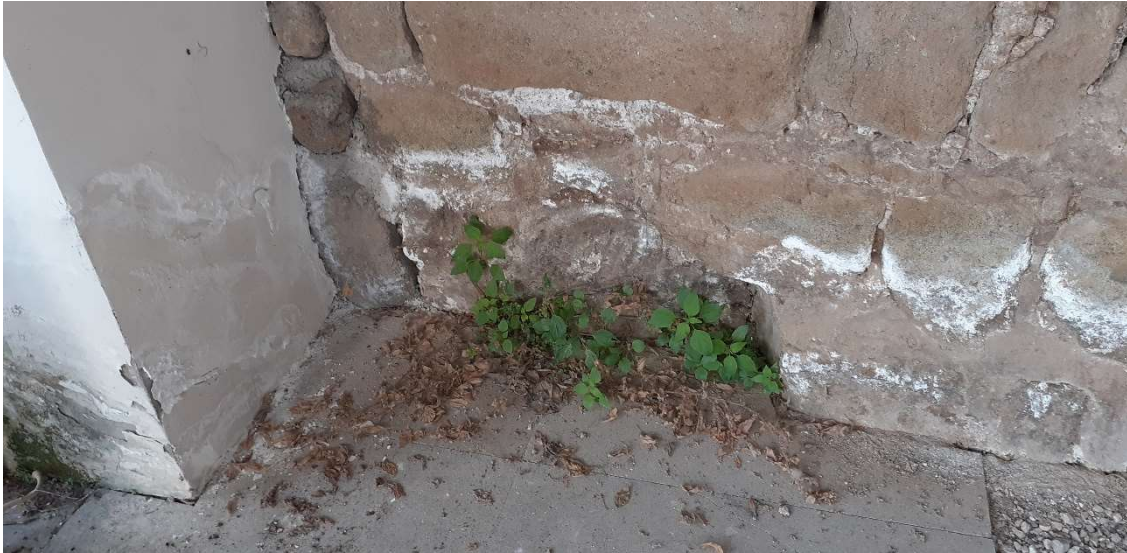
Foto 32 – Vista della patina biancastra dovuta ad efflorescenza sui resti murari storici interni al fabbricato
