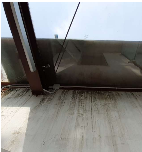
Foto 26 – Vista delle macchie sulle pareti interne
