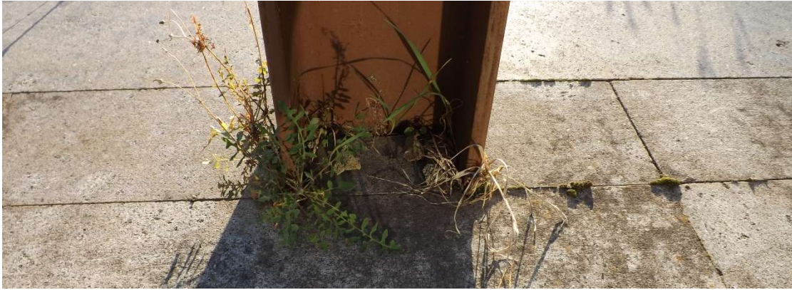
Foto 34 – Vista della presenza di vegetazione infestante alla base degli elementi strutturali del fabbricato
